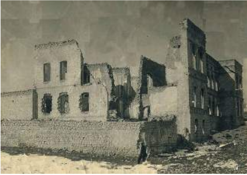
22 mart 1920-ci ildə ermənilərin azərbaycanlılara qarşı təşkil etdikləri silahlı basqın nəticəsində möhkəm dağıntılara məruz qalmış məktəb binası Разрушенное и сожженное армянами здание школы, во время вооруженного нападения на мирных азербайджанцев 22 марта 1920 г.
