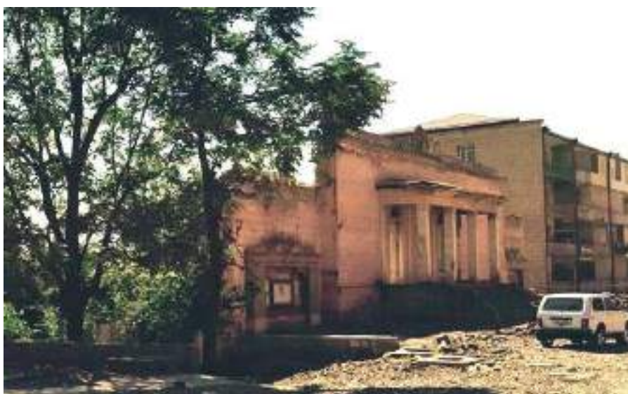
Musiqi məktəbinin binası. XIX əsrin memarlıq abidəsidir. M.Ə.Rəsulzadə küçəsi. Здание музыкальной школы. Памятник архитектуры XIX в. Ул. М.А.Расулзаде.
