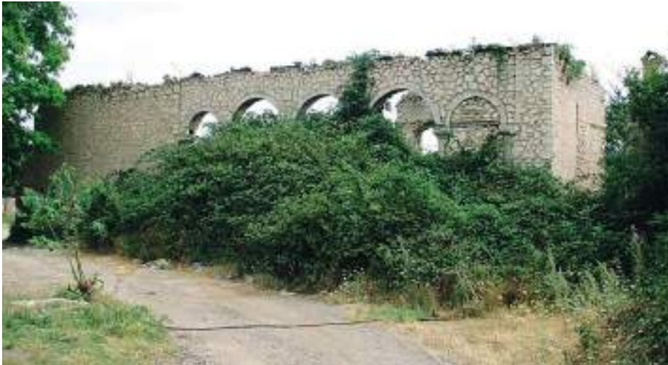
Merdinli məhəlləsinin məscidinin xarabalıqları. XIX əsrin memarlıq abidəsidir. İşğaldan sonra dağıdılmışdır. Руины мечети квартала Мердинли. Является памятником архитектуры XIX в. Была разрушена после оккупации города армянскими вооруженными формированиями 08.05.1992 года.
